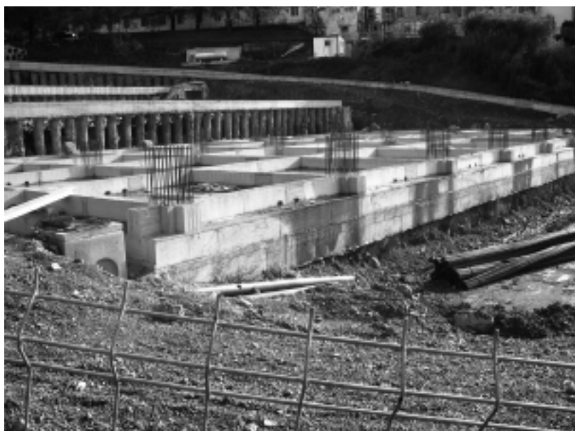
Il parcheggio in costruzione in località Cappuccini
